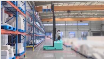
Almacenamiento y recuperación en altura en almacenes junto a la línea
